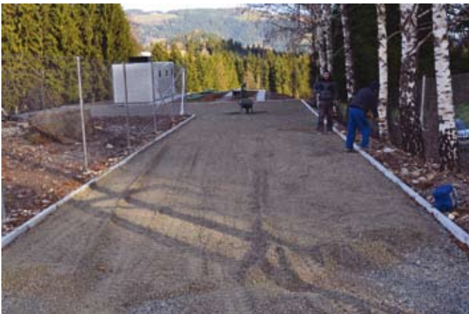
Lepo umeščena čistilna naprava Josipdol, manjka le še asfalt
