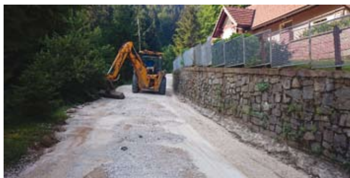
Klanec med sanacijo
