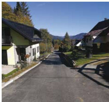
Zaključena kanalizacija in vodovod v Zgornjem Lehnu
