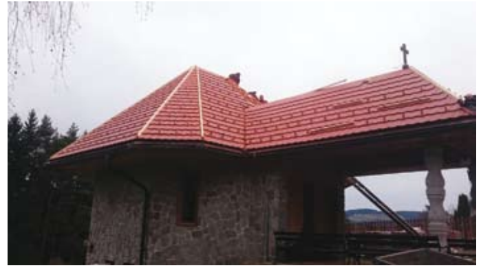
Obnova strehe na poslovilnem domu je bila potrebna
