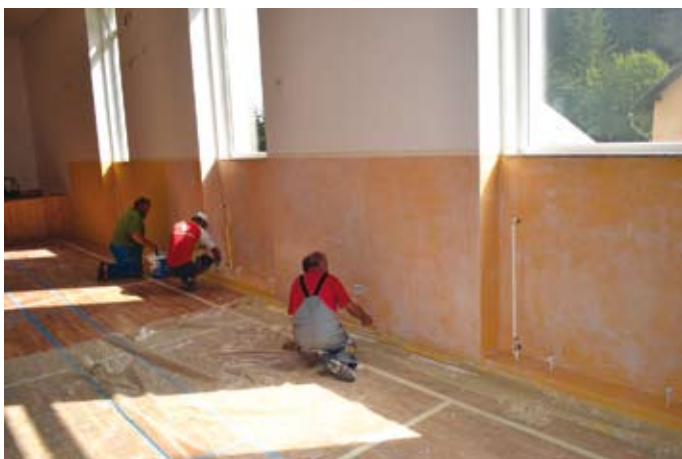
Mnogo postorijo sami člani društev, Občina prispeva material, člani opravijo delo. Slika prikazuje beljenje dvorane v Josipdolu
