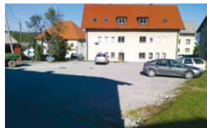
Parkirni prostor pred obnovo
