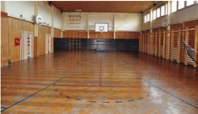
Stari parket je zahteval obnovo, saj je bil že nevaren za uporabnike
