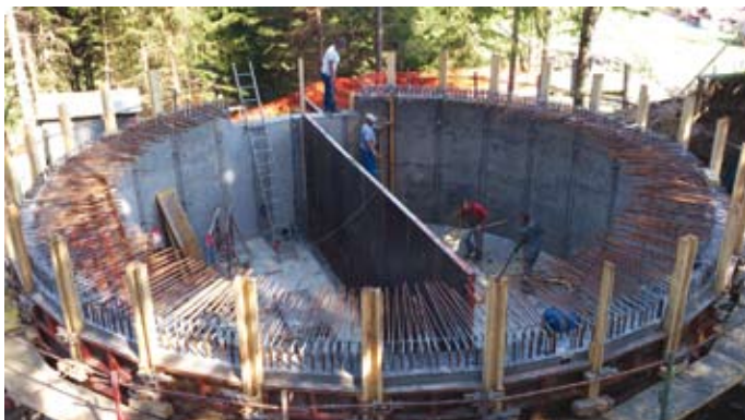
Vodohran za 200 m 3 v Ribnici na Pohorju v izgradnji
