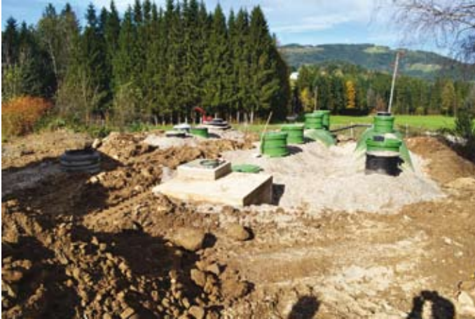
Nova čistilna naprava Josipdol v gradnji
