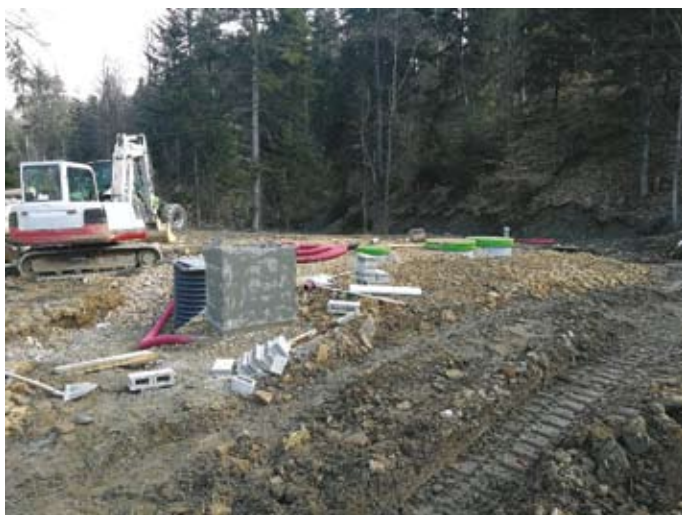
Izgradnja čistilne naprave Zgornji Lehen
