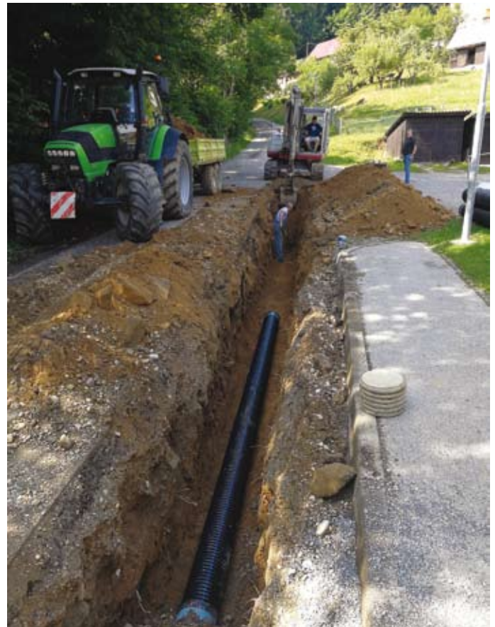
Kanalizacija Josipdol je bil najzahtevnejši projekt zadnjih let
