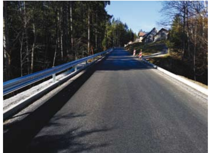
Drugi del rekonstrukcije državne ceste Ribnica na Pohorju–Podvelka
