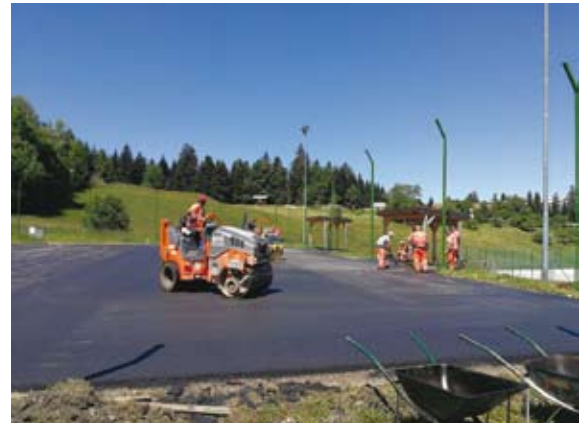
Nov asfalt na igrišču v Josipdolu
