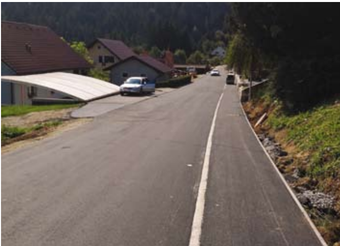
Izgradili smo hodnik za pešce in javno razsvetlavo ob cesti Ribnica na Pohorju–Ribniška koča
