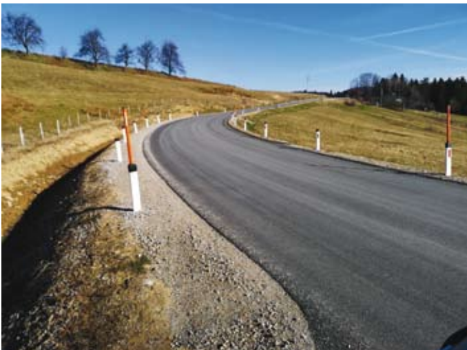
Prvi del rekonstrukcije državne ceste Ribnica na Pohorju–Podvelka
