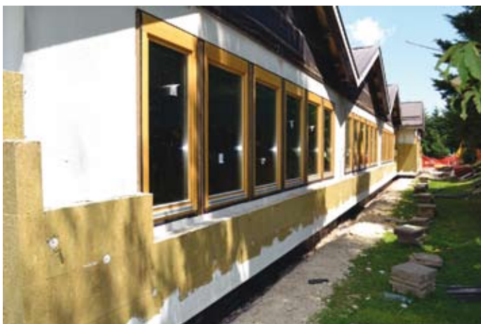
Opravili smo energetske sanacije osnovne šole in zamenjali stavbno pohištvo
