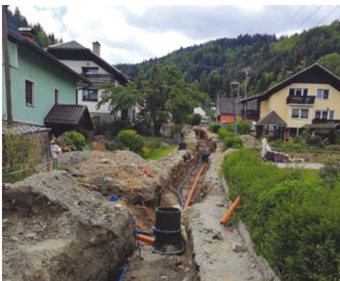
Kanalizacija Zgornji Lehen v izgradnji
