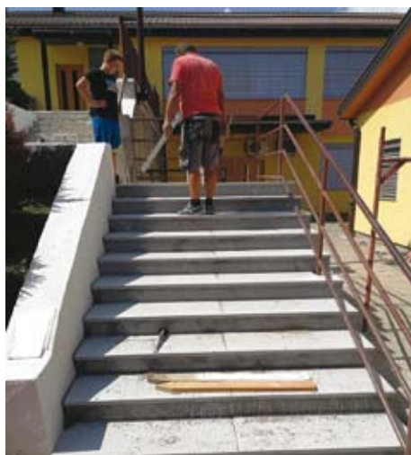
Novo granitno stopnišče pri osnovni šoli
